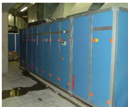
Fotografies de bombes de calor deshumectadores, en sala tècnica i en coberta.
