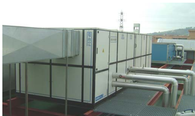
Fotografies de bombes de calor deshumectadores, en sala tècnica i en coberta.
